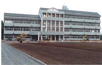
新校舎建設、校庭造成
