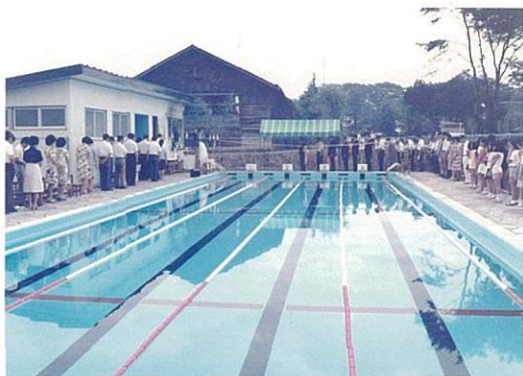
昭和50年 8月 プール完成
