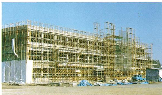
昭和54年 校舎改築
